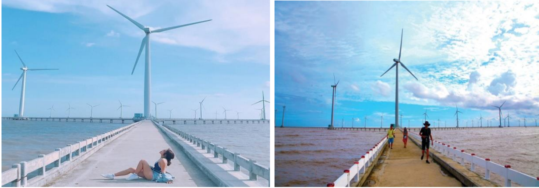
Điện gió Bạc Liêu
